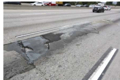
▲工事ではアスファルトの再舗装によりひび割れや穴を修復。舗装距離は約1.4km、費用は約180万米ドル。
