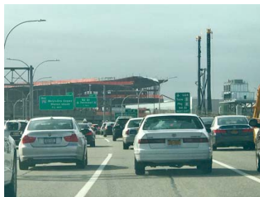
▲ニューヨーク市ラガーディア空港につながる高速道路。空港では新ターミナルの建設が進む。
