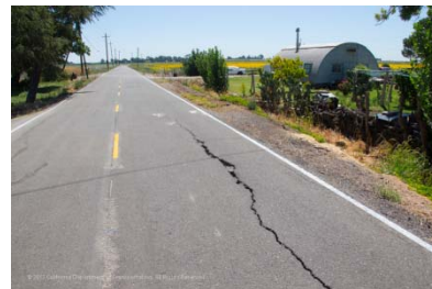
▲工事ではアスファルト乳剤と骨材を使用し、道路のさらなる劣化を予防。舗装距離は約30km、費用は約170万米ドル。
